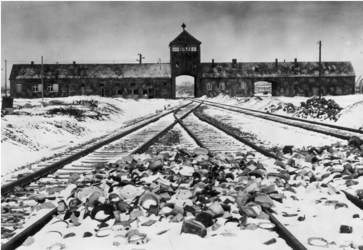
Ingresso del campo di concentramento di Auschwitz-Birkenau
